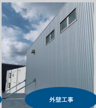
サイディング工事
